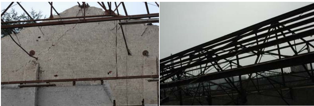
Het dak wordt volledig gerenoveerd.
